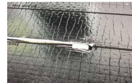
3. Bodensensor montieren
