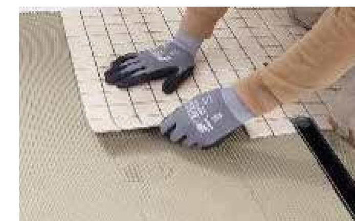
6. Verklebung der Fliesen
