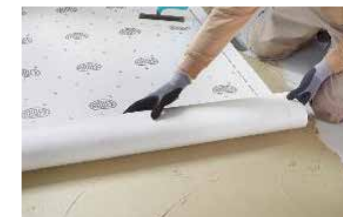
5. Auslegen der Abdichtbahn
