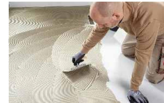
2. Aufbringen des Fliesenklebers
