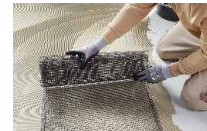
3. Auslegen von thermoheld •FLIESE• direkt in den Kleber
