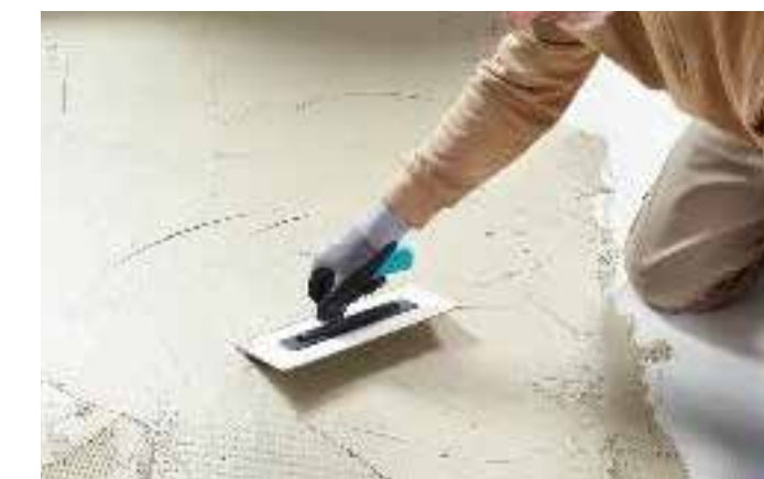
4. Komplettes Einbetten des Glasfasergitters
