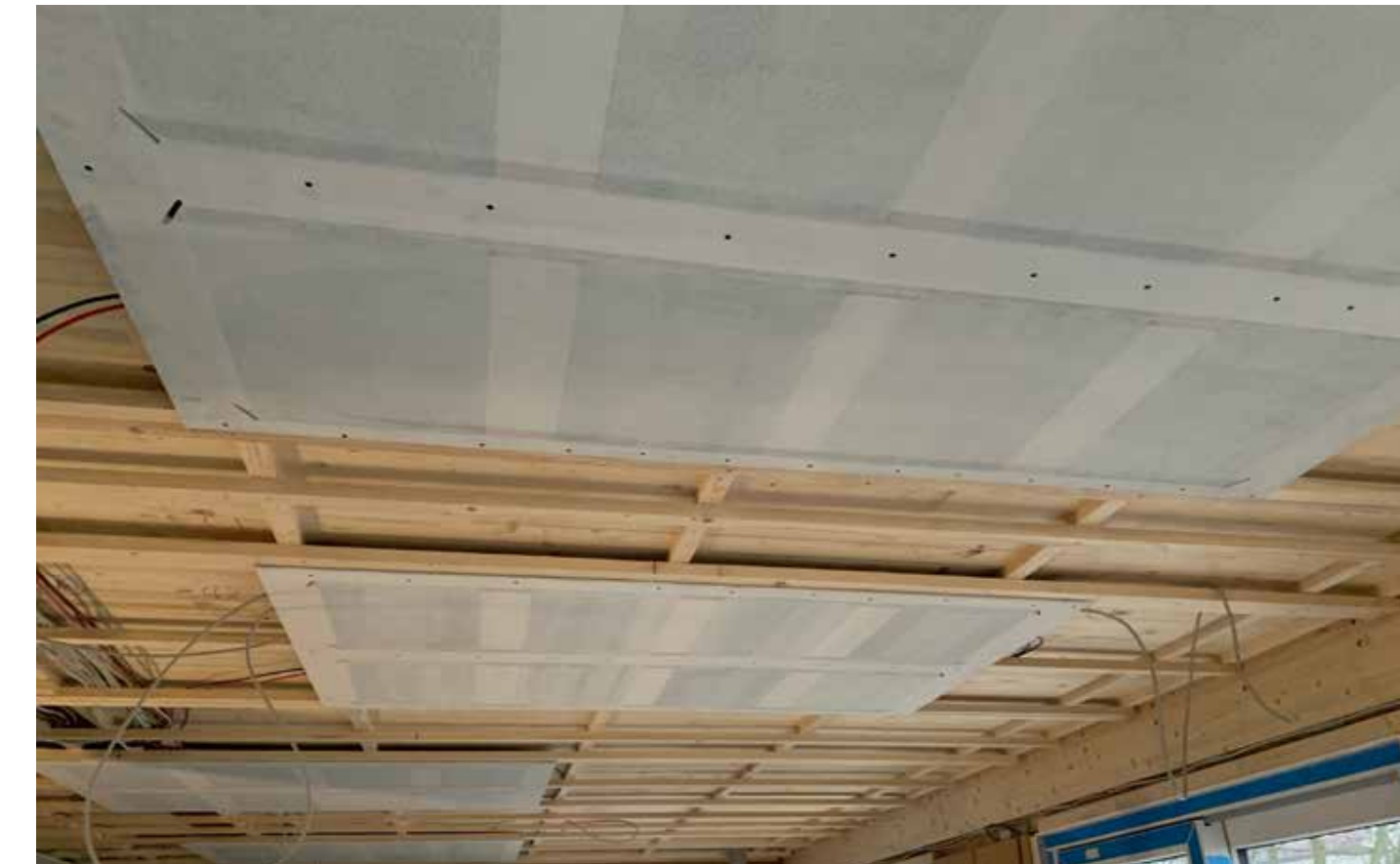
thermoheld •WAND• bei der Installation als Deckenheizung
