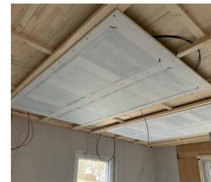
thermoheld •WAND• bei der Installation als Deckenheizung
