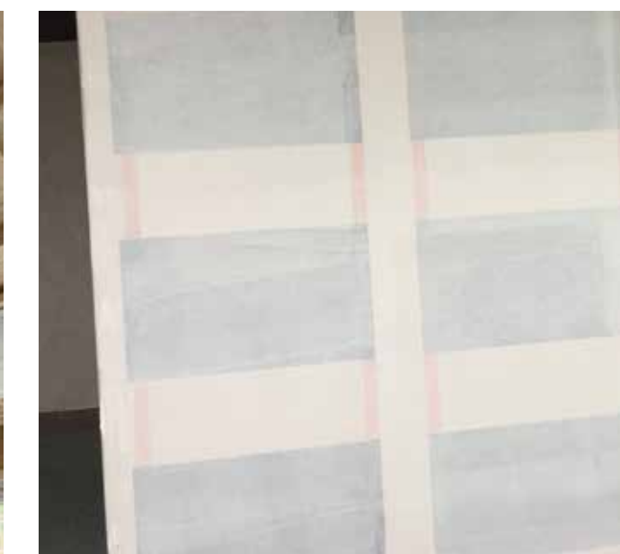
thermoheld •WAND• bei der Installation als Deckenheizung
