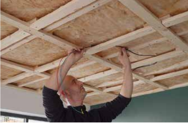
1. Verlegen der Kabel in der Unterkonstruktion
