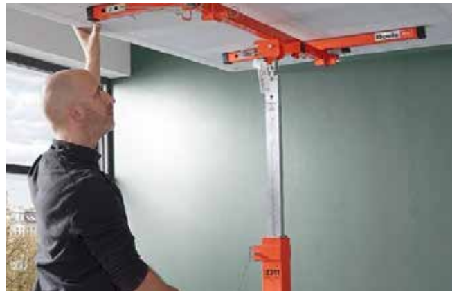
4. Platte an der Decke positionieren
