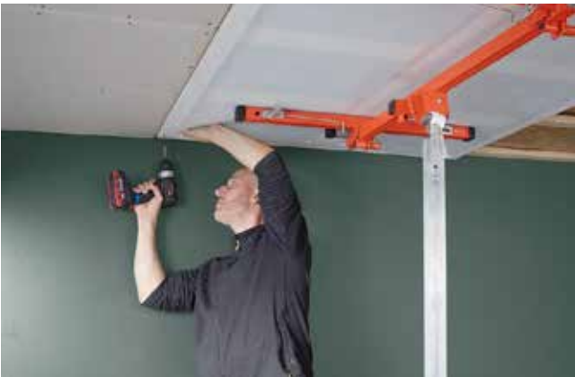
5. Anschrauben, dabei Trockenbau-Standard beachten
