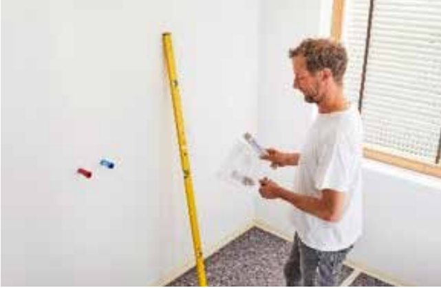
1. Zuerst die gewünschte Position der Heizfläche anzeichnen
