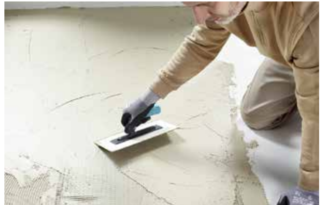
4. In die Abdichtmasse/den Kleber eindrücken
