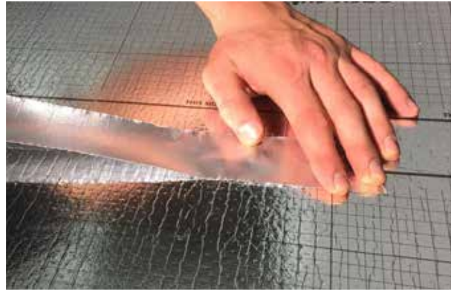
2. Abdichten der Wasserdampf-Diffusionssperre mit Alu-Band
