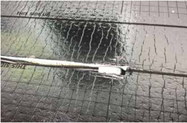
1. Trittschalldämmung legen (+ Diffusionssperre), für Bodenfühler schlitzen
