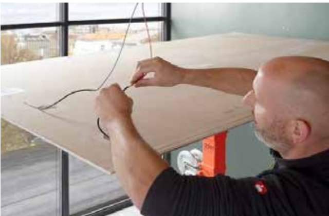
3. Kabel anschließen
