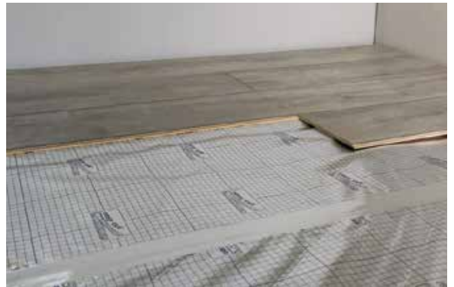
6. Bodenbelag, hier Laminat, verlegen
