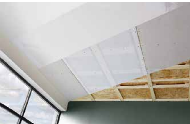
7. Deckenaufbau nach dem Streichen
