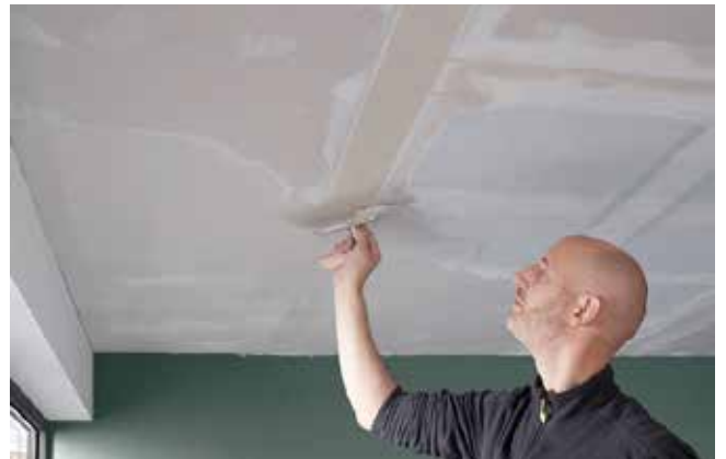
6. Verspachteln, dabei die Heizflächen nicht zerkratzen
