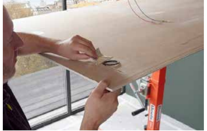
2. Aufkleber über den eingerollten Kabeln lösen
