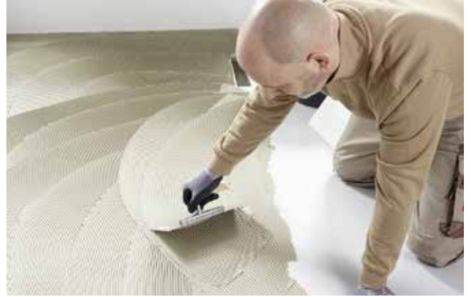
2. Als nächstes die Abdichtmasse/den Kleber auftragen
