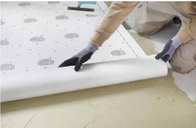
5. Die Abdichtbahn auflegen
