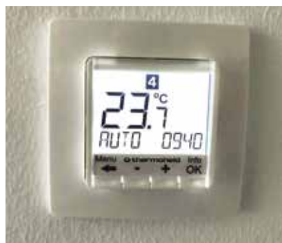
Eingebauter Raumtemperaturregler
