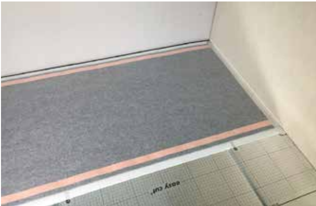
3. thermoheld ·BODEN· abrollen & Ränder mit Klebeband befestigen
