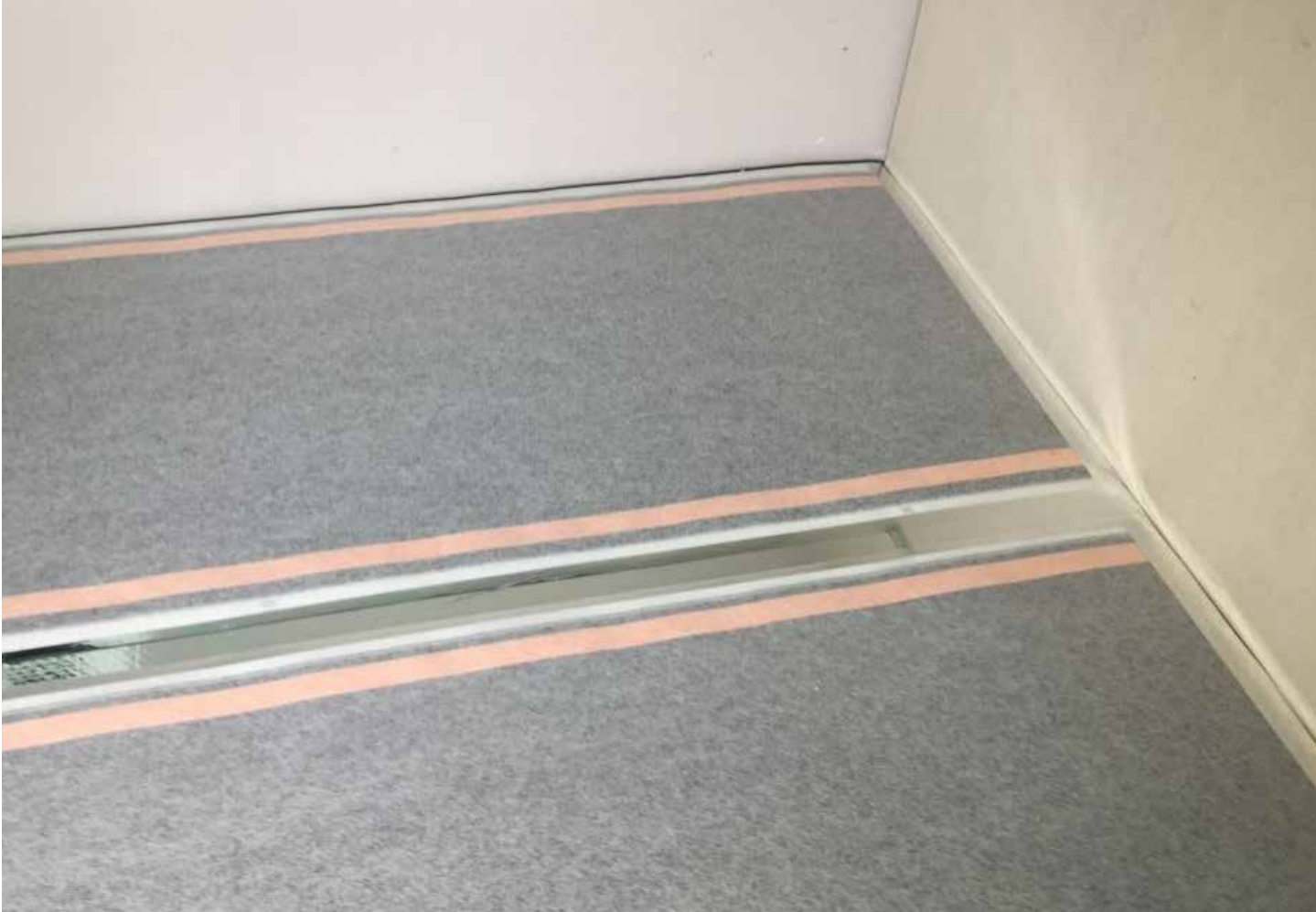
thermoheld ·BODEN· bei der Montage im Wohnbereich
