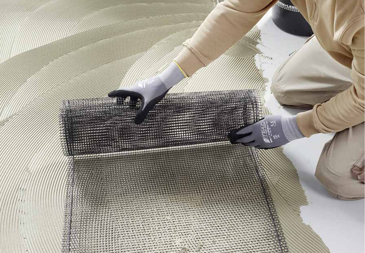
thermoheld ·FLIESE· beim Einbau im Badezimmer
