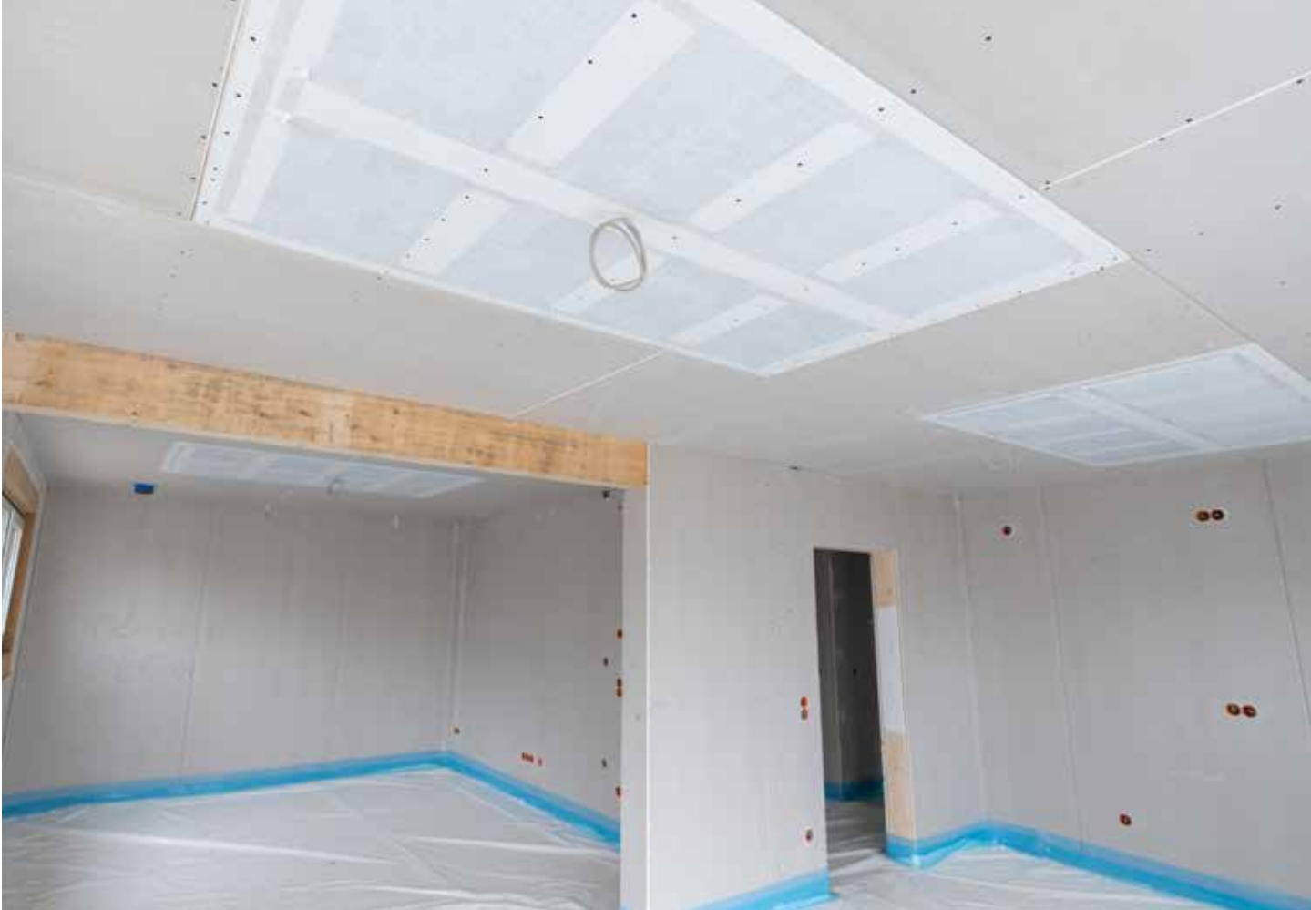
thermoheld ·WAND· im Einsatz als Deckenheizung
